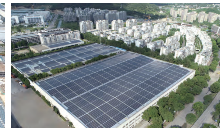
30MW ☰ Centrale elettrica BIPV Jintian Copper 📍 Ningbo, provincia di Zhejiang, Cina
