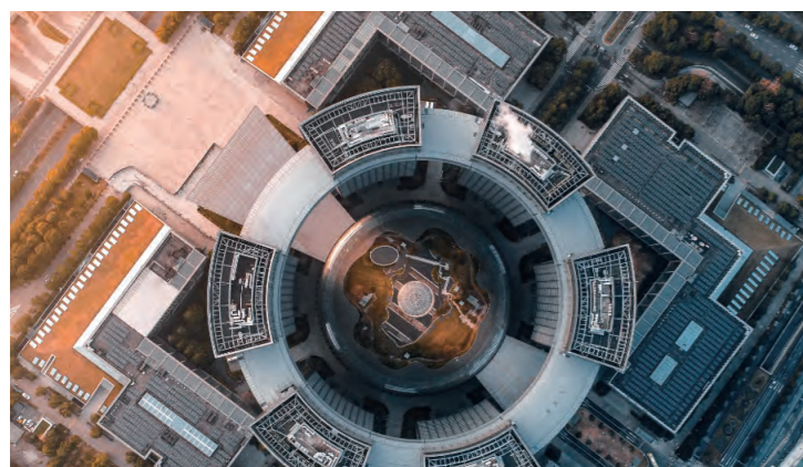
1,2MW ☰ Centrale fotovoltaica sul tetto del podio del Centro Civico 📍 Hangzhou, provincia di Zhejiang, Cina
