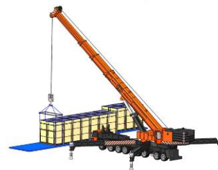
Scarico del pacchetto verticale sul lato lungo con gru
